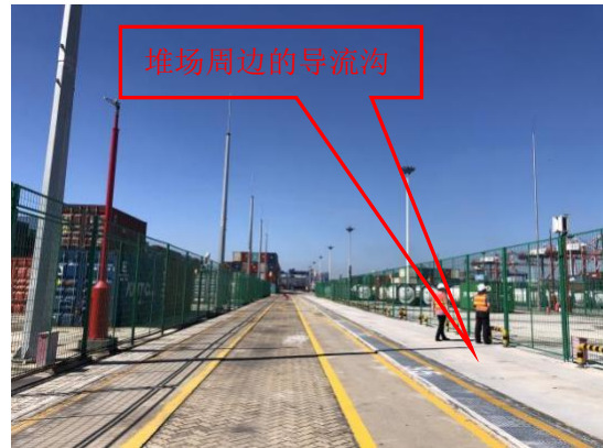
堆场外道路及周围导流沟
