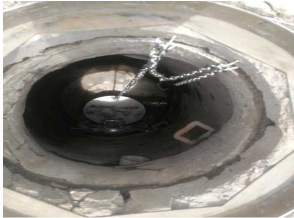
码头前沿手动雨水截止阀
